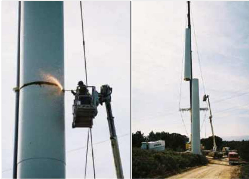
Figure 23 : Découpage et démontage d'une éolienne (Sallèles-Limousis (France), 2010).
