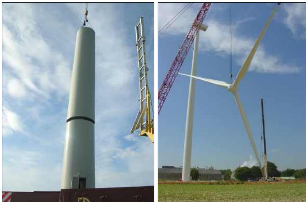
Figure 16 : Différentes étapes du montage d'une éolienne (source : parcs éoliens d'Engie-Electrabel).
