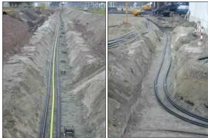
Figure 15 : Travaux de pose de câbles de raccordement (source : parcs éoliens d'Engie-Electrabel).
