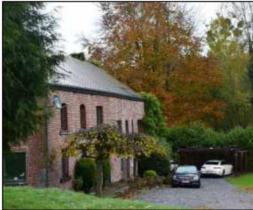
A : vue de la façade sud-est de l'habitation sise rue du Moulin n°3.
