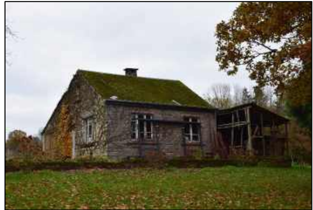
B : vue des façades sud-est et nord-est de l'habitation sise rue du Moulin n°1.
