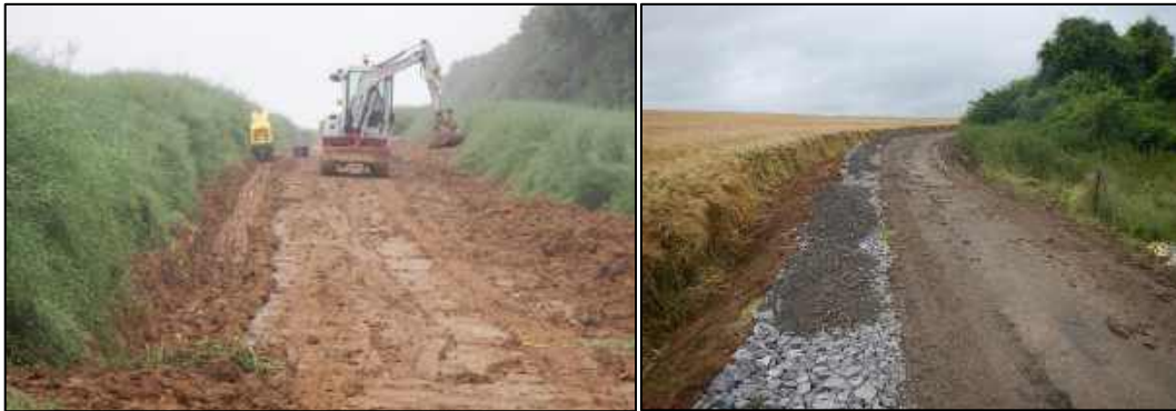
Figure 14 : Décapage du sol en vue de la création d'un nouveau chemin d'accès avec stockage des terres arables en merlons (photos : Luminus, parc éolien de Héron, 2016).
