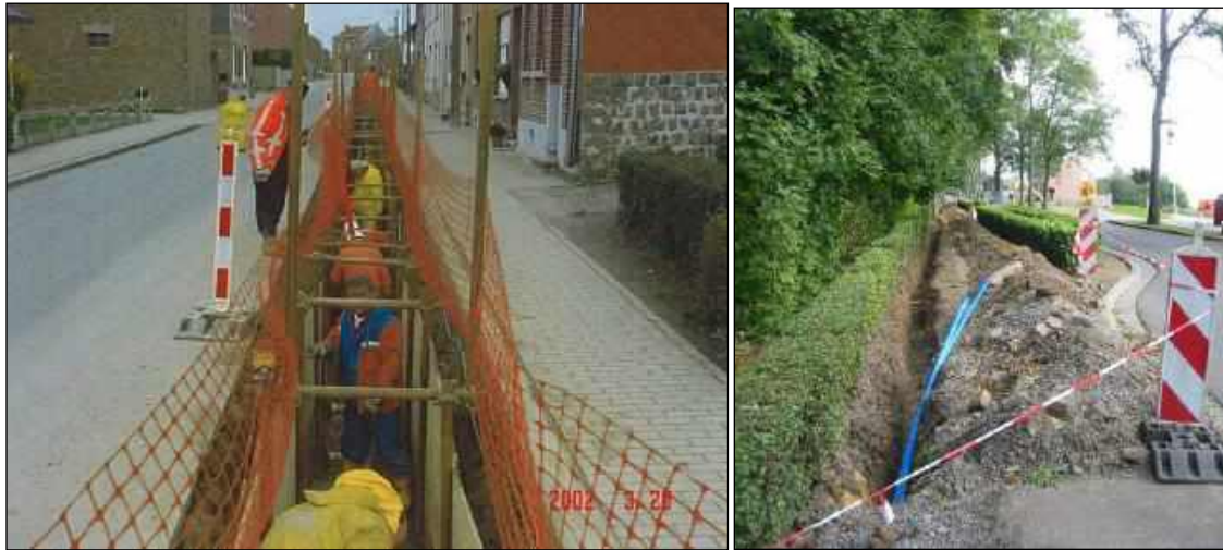
Figure 17 : Tranchées classiques en voirie (à gauche) et en accotements (à droite) (source : Elia, CSD).
