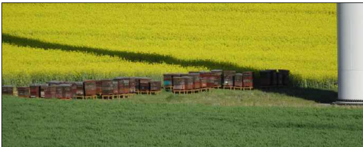
Figure 101 : Ruches en activité installées au pied d'une éolienne du parc éolien de Ciney-Pessoux en Wallonie (CSD, 2020).
