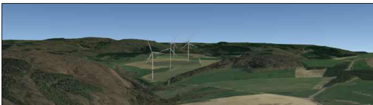
Figure 118 : Vue aérienne du projet depuis le nord-nord-ouest (source : Google Earth, 2020 ; facteur d'exagération du relief : 2x).
