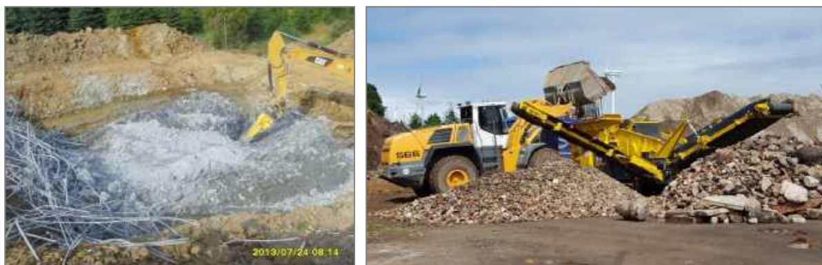
Figure 22 : Démantèlement de la fondation d'une éolienne – séparation des fers et concassage du béton (Schmees Bau GmbH, 2013).
