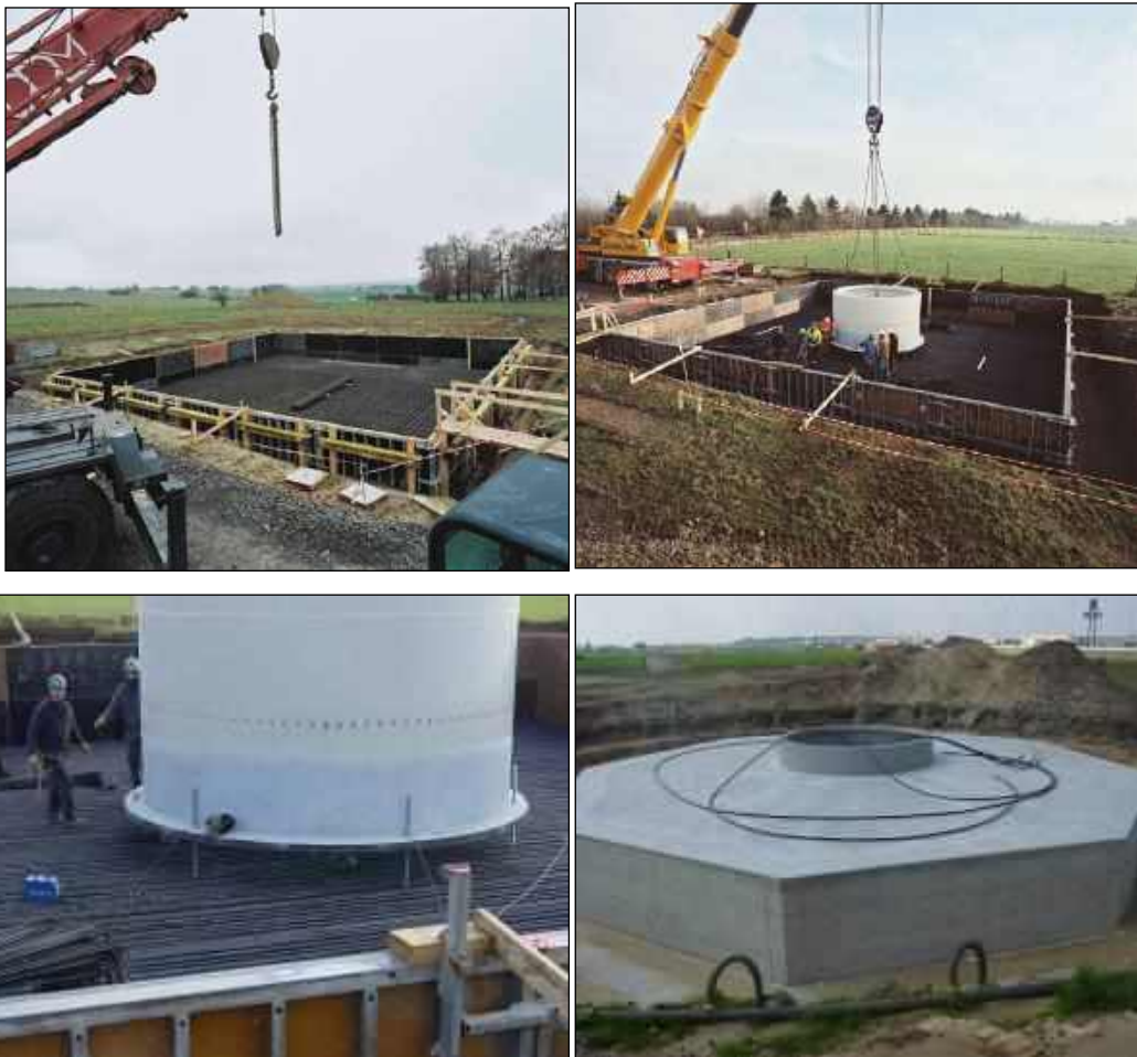
Figure 23 : Aire de montage au pied d'une éolienne (source : parcs éoliens d'Engie-Electrabel).
